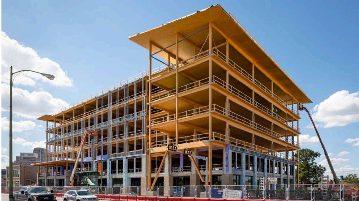
Estructura en madera laminada y forjado de CLT
